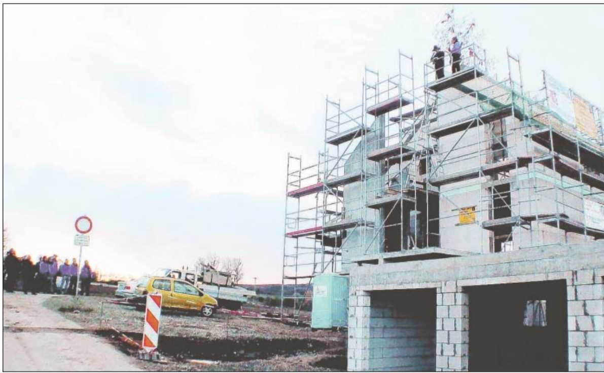
Nach gut zwei Monaten Bauzeit wurde Richtfest am Mehrfamilien-Passivhaus gefeiert. Es wird im Hettlenleidelheimer Neubaugebiet „Staufer Weg“ gebaut.
